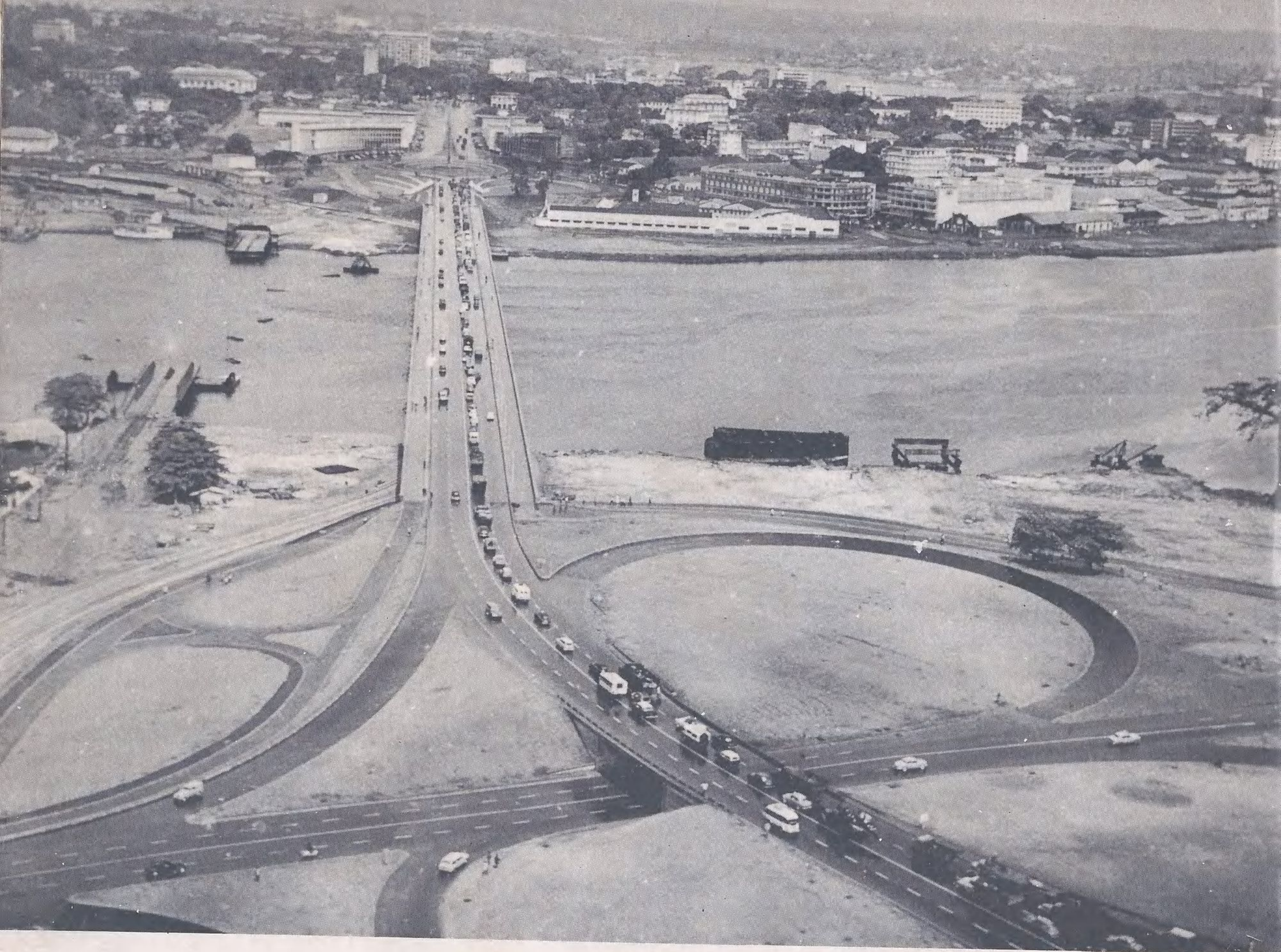
Abidjan : un pont, une lagune, des bâtiments extra modernes, un dynamisme exceptionnel.
